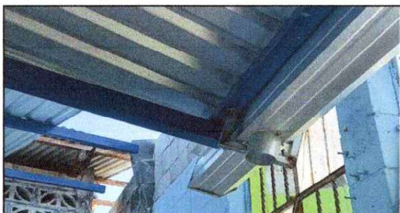
FOTO 3: Sustrucción de canal de metal Y Reparación de bajada de agua pluvial, tubo PVC 3"
