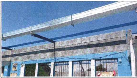
FOTO 11: Reparación de muro perimetral de block.
