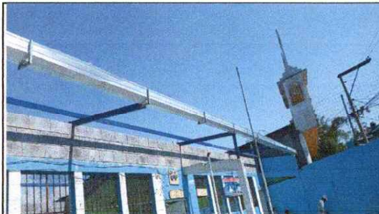
FOTO 9: Sustrución de canal de metal
